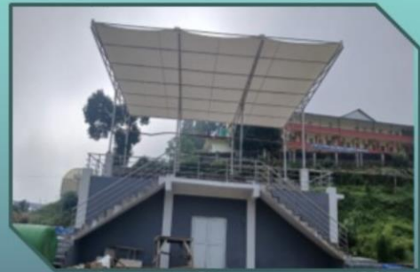
करफोक विद्यालयको खेलमैदानमा स्टेज र प्यारफिट निर्माण
